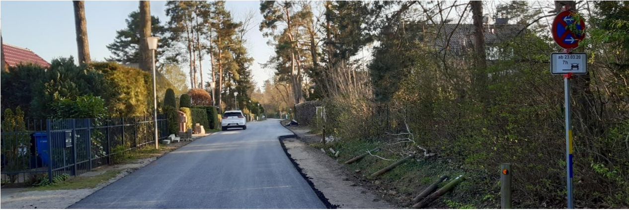
Wenige Tage vor Ostern: Erneuerung der Tristanstraße
