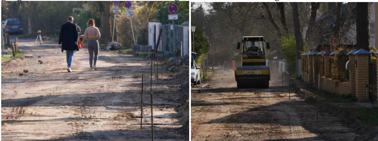
Der alte Belag musste abgetragen werden: Baustelle Tristanstraße Ende März
