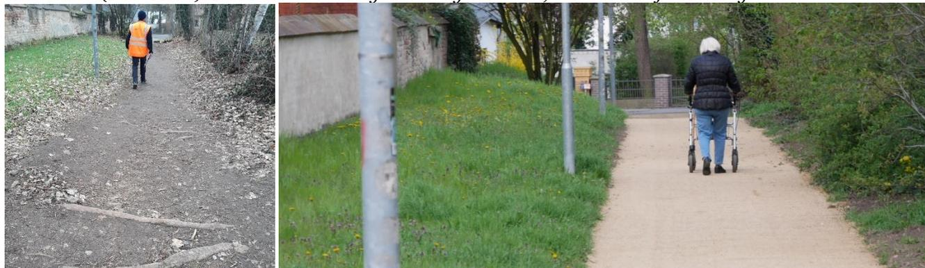
Fußweginspektion entlang der Friedhofsmauer mit Herrn Standke vom Tiefbauamt am 1. März (Foto links): Meine Ortsbeiratskollegin Regina Ryssel (CDU) hatte mich darüber informiert, dass Stolperkanten bereits zu Stürzen älterer Menschen geführt hatten. Nun ermöglicht die glatte wassergebundene Decke auch die Nutzung mit Rollatoren (Foto rechts). Für den Zugang vom Triftweg aus wurde die Bordsteinkante abgesenkt.
