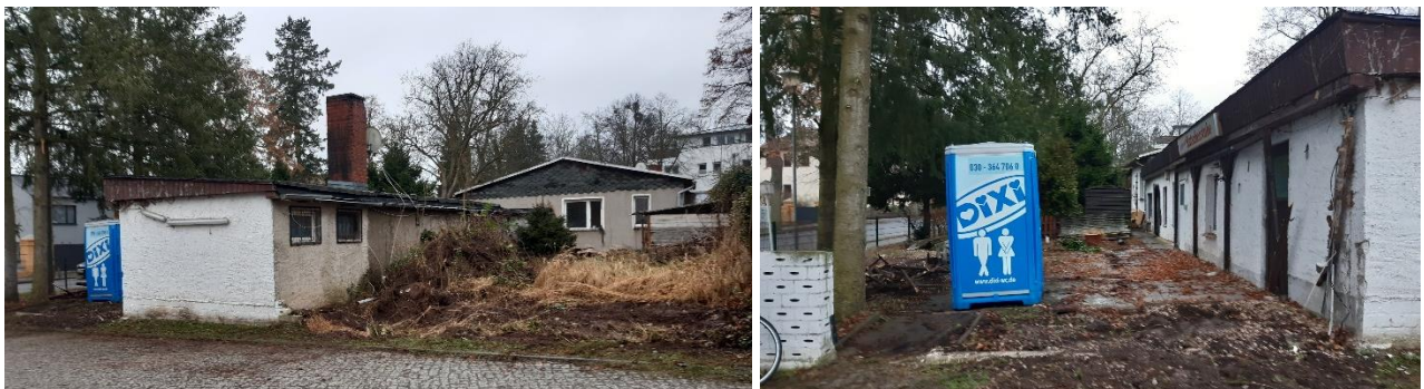
Die Grundstücksmauer ist weg, die Abrissarbeiten haben begonnen.
