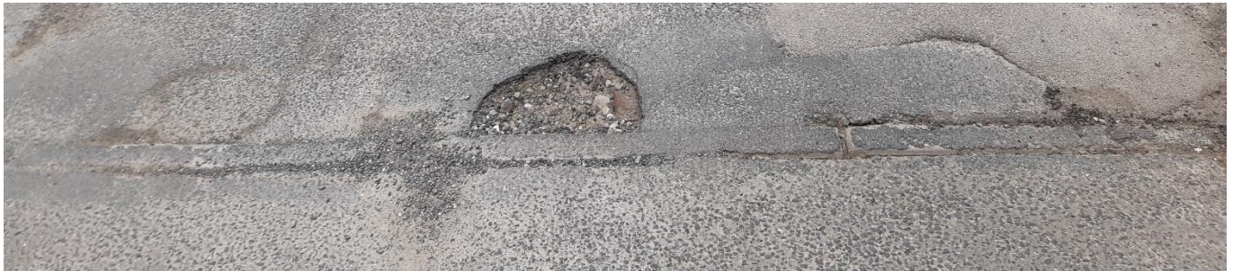
Am Ende des Winters: Reparaturbedarf an Dünnschichtdecken
